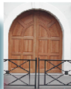
porte (réalisation SARL Guillou)
